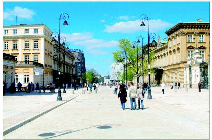
Fot. 12. Krakowskie Przedmieście po remoncie (fot. arch. Mostostal Warszawa)
