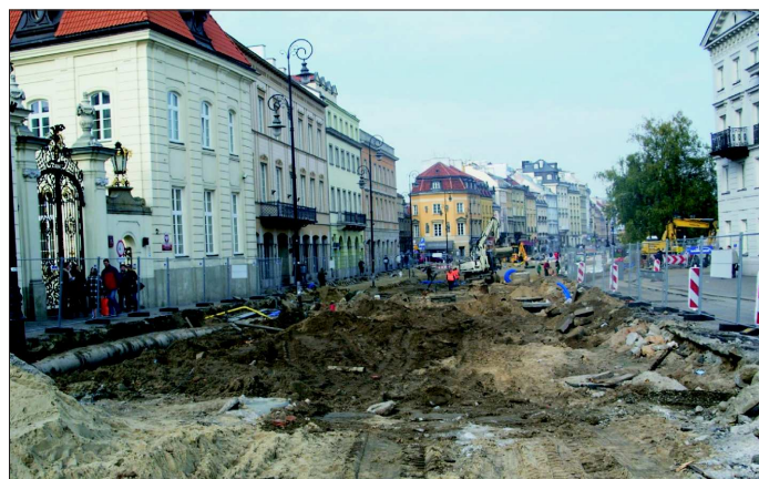
Fot. 6. Prace rozbiórkowe starych instalacji podziemnych (fot. Jacek Krzemiński)
