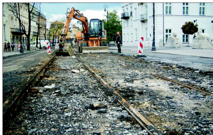
Fot. 5. Przedwojenne torowisko tramwajowe pod nawierzchnią asfaltową (fot. Jacek Krzemiński)
