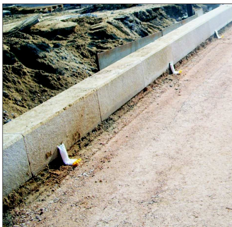
Fot. 8. Ułożone drenaż perforowane (fot. Jacek Krzemiński)
