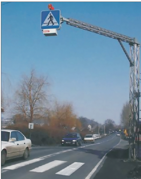
Fot. 1. Kratowe stalowe konstrukcje wsporcze
