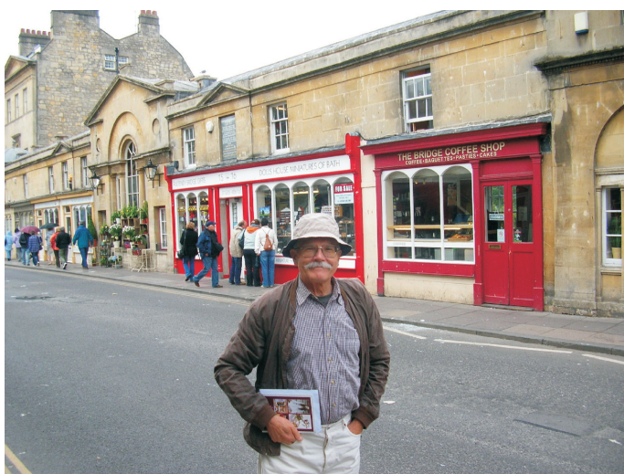
Fot. 49. Zabudowa Pulteney Bridge w Bath
