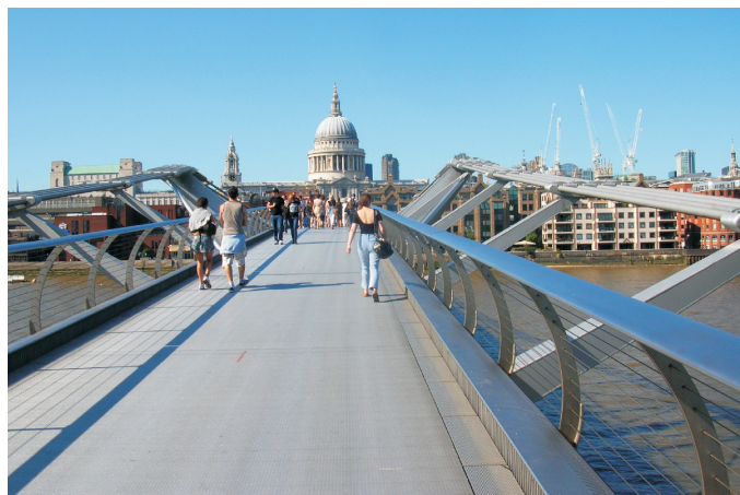
Fot. 58. Pomost kładki Millennium w Londynie
