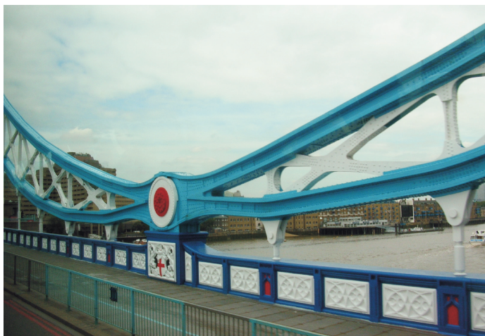
Fot. 51. Tower Bridge – połączenie dwóch części łańcucha
