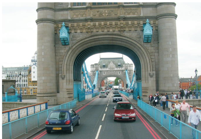
Fot. 53. Widok na podnoszoną część pomostu Tower Bridge
