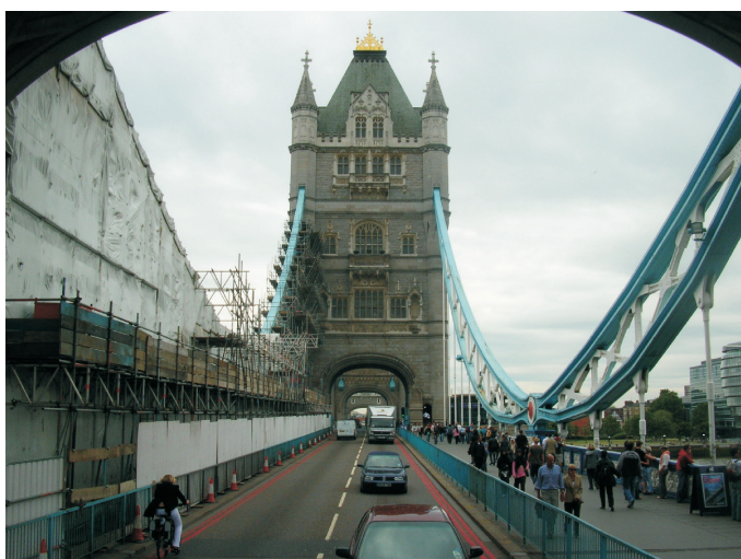
Fot. 52. Widok z pomostu na jedną z wież Tower Bridge
