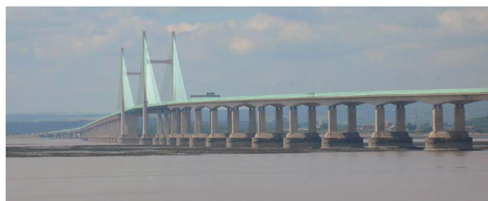
Fot. 43. Second Severn Crossing – drugi most przez ujście Severn z 1996 r.
