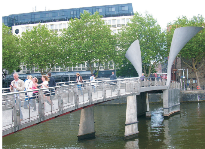
Fot. 47. Kładka Pero's Bridge z przeciwwagami w Bristolu
