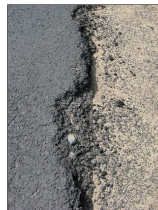
Fot. 1. Zniszczenia nawierzchni asfaltowej przy krawędzi zewnętrznej: a) skutki powierzchniowego wychłodzenia na krawędzi w budowywanej mma, b) ubytki nawierzchni w wyniku przechłodzenia w całym przekroju warstwy
