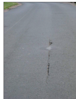
Fot. 2. Zniszczenia nawierzchni asfaltowej w obszarze krawędzi wewnętrznej: a) ubytki powierzchniowe, b) uszkodzenia wgłębne o nie-wielkiej szerokości
