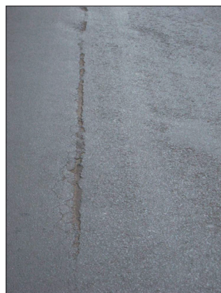
Fot. 2. Zniszczenia nawierzchni asfaltowej w obszarze krawędzi wewnętrznej: a) ubytki powierzchniowe, b) uszkodzenia wgłębne o nie-wielkiej szerokości
