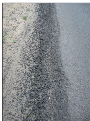
Fot. 1. Zniszczenia nawierzchni asfaltowej przy krawędzi zewnętrznej: a) skutki powierzchniowego wychłodzenia na krawędzi w budowywanej mma, b) ubytki nawierzchni w wyniku przechłodzenia w całym przekroju warstwy
