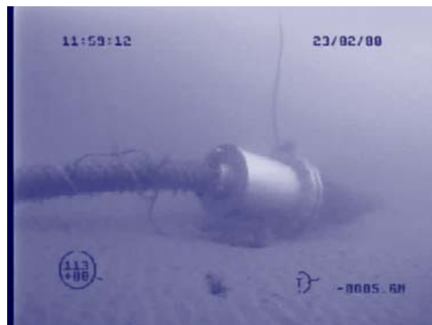
fot. 4. Kabel podmorski – antropogeniczny obiekt podwodny technologiczny, Morze Bałtyckie, fot. Instytut Morski w Gdańsku.
