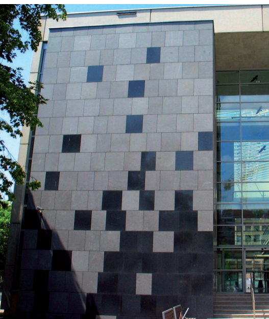
Ryc. 4. Elewacja z diorytu przedborowskiego w dwóch fakturach polerowanej i piaskowanej (fot. S. Mazurek)
