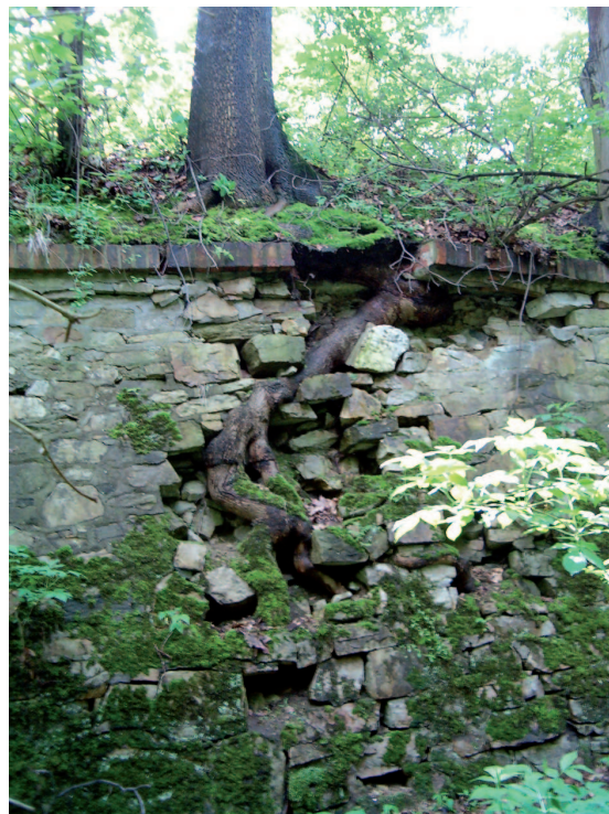
Ryc. 19. Niszczący wpływ zieleni na strukturę budowli (fot. J. Potyrała)
