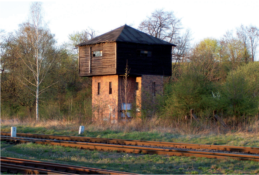
Ryc. 1. Stacja Głuchołazy – wieża wodna
