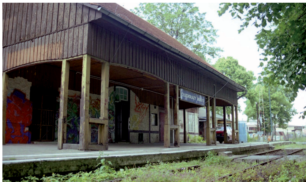
Fig. 5. Głuchołazy Miasto railway stop – platform arcade
