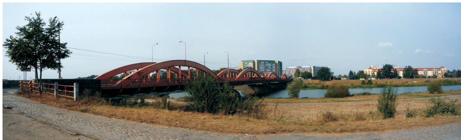
Fig. 5. View of the Trzebnickie Bridges
