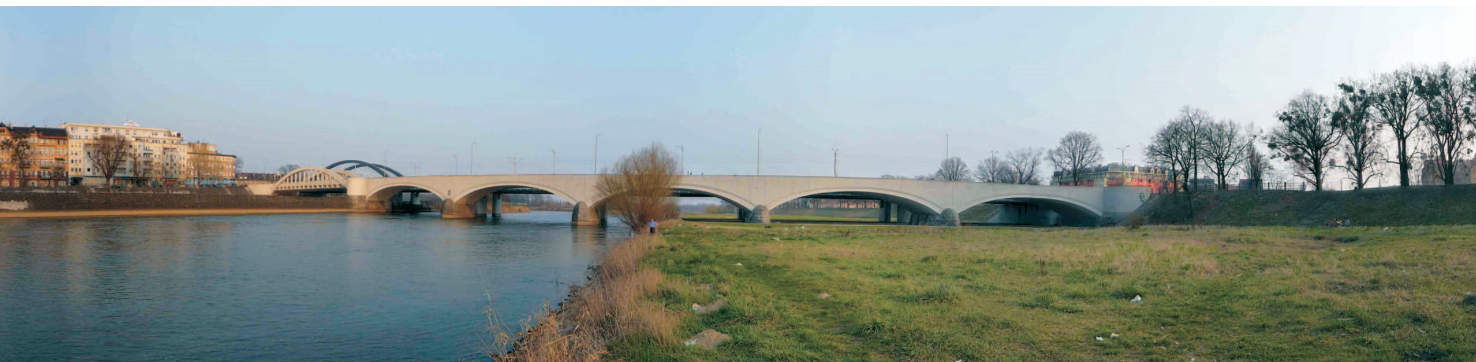
Ryc. 4. Widok na Most Warszawski
