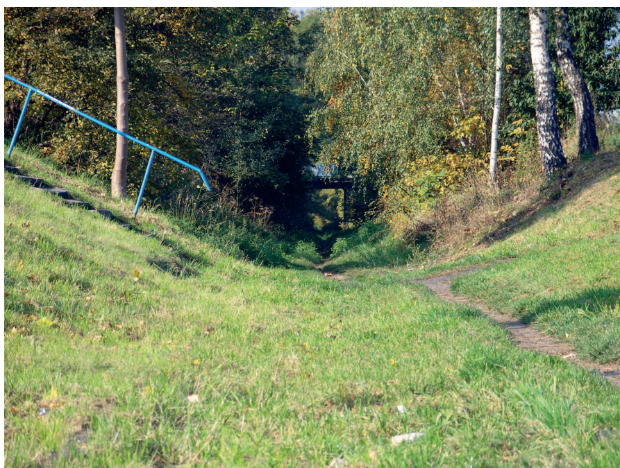
Ryc. 7. Nieczynne torowisko – trasa w wykopie
