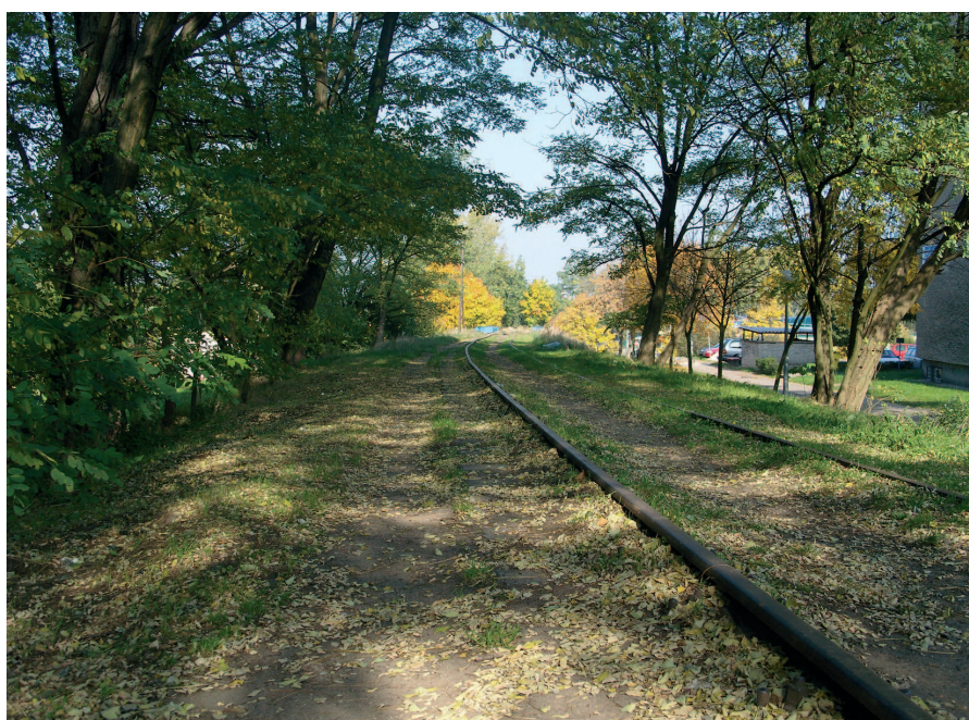
Ryc. 5. Nieczynne torowisko – trasa między osiedlami
