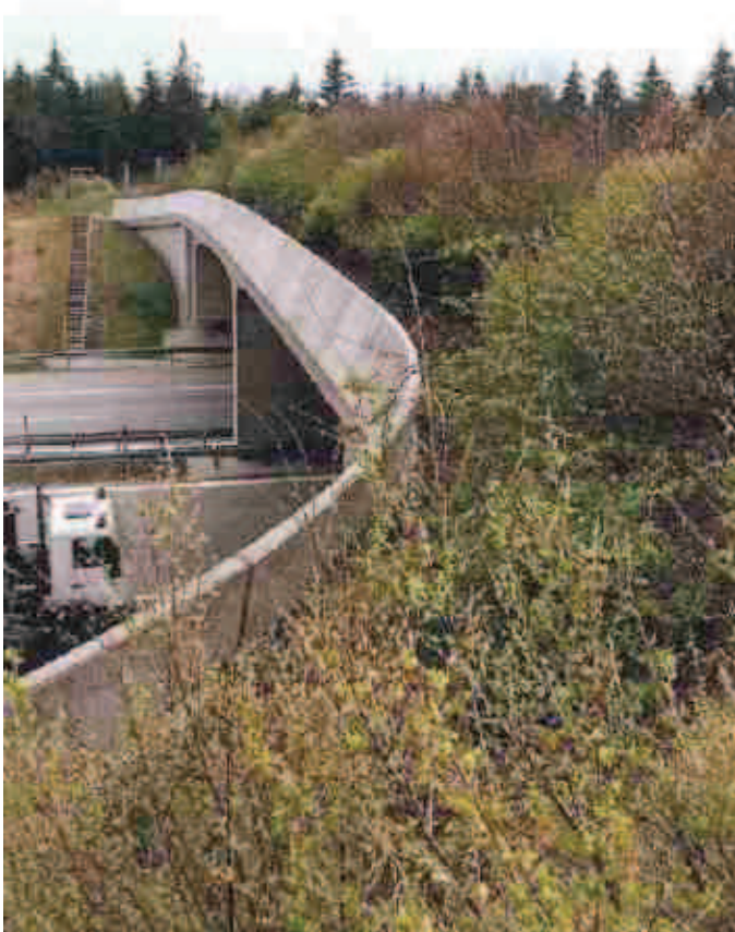
Rys. 8. Prawidłowo wykonane przejście w Bawarii, 70 m szerokości
