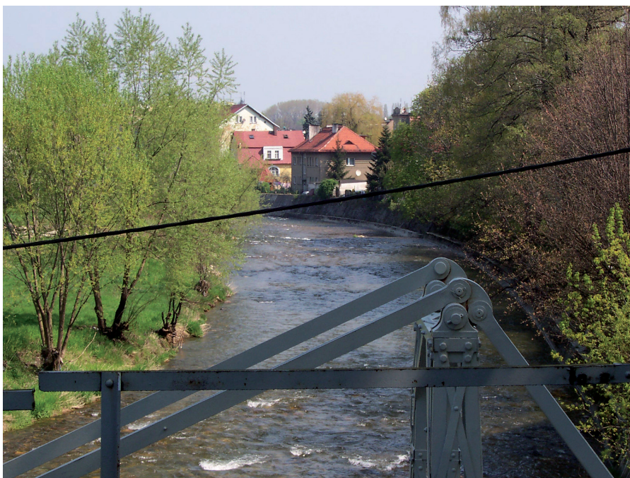
Widok z mostu nad Białą Głuchołaską w kierunku północnym
