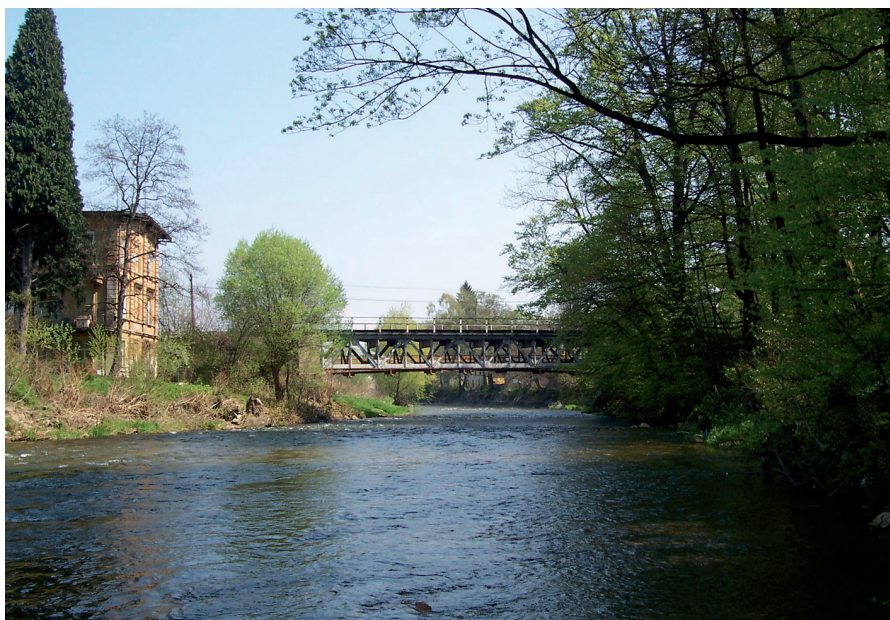
Widok na most kolejowy nad Białą Głuchołaską od strony południowej
