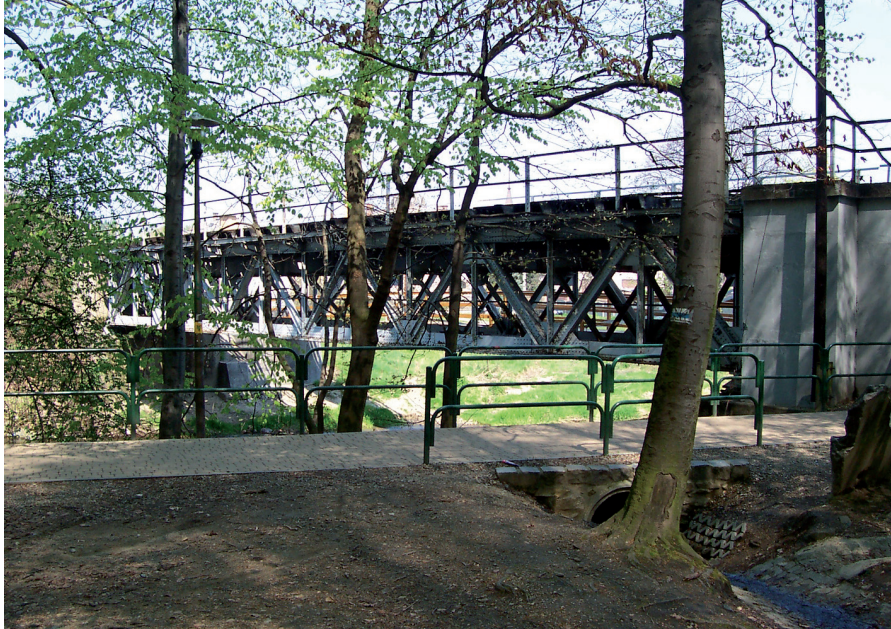
Ażurowa konstrukcja mostu nad Białą Głuchołaską
