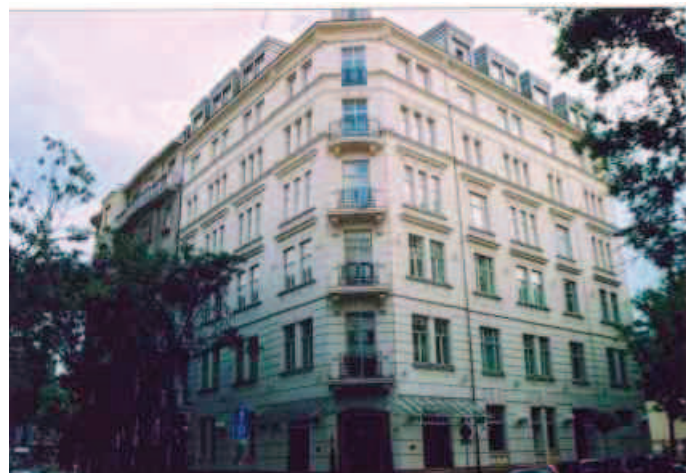
Fot. 5. Hotel „Rialto” w kamienicy z roku 1906 przy ul. Wilczej (fot. Anna Pawlikowska-Piechotka, 2008)
