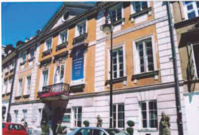
Fot. 1. Muzeum Marii Skłodowskiej-Curie w kamienicy przy ul. Freta w Warszawie, urządzone w domu rodzinnym uczoneyj (fot. Anna Pawlikowska-Piechotka, 2008)
