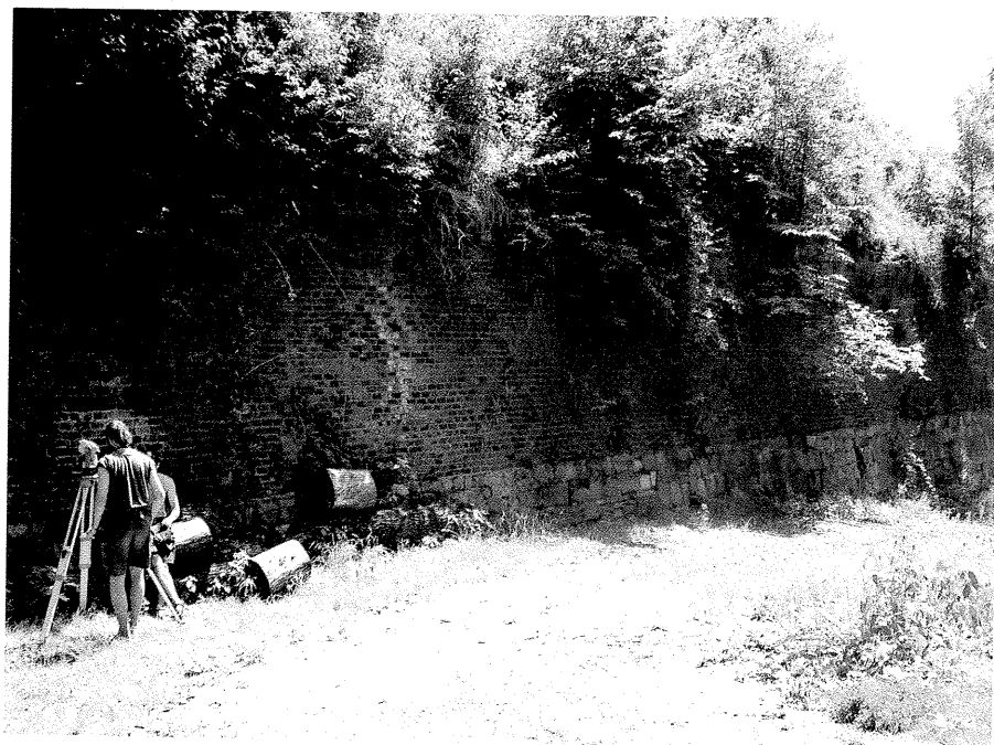
Bujnie rozwinięta roślinność zagraża stabilności konstrukcji muru skarpy w fosie Reduty Króliczej Fot. W. Bartczak
