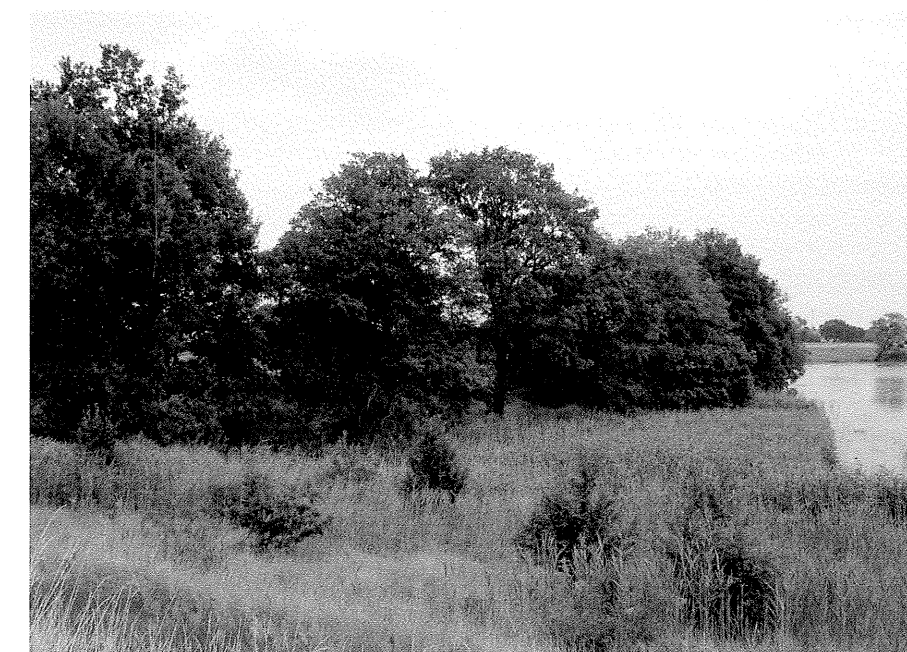
Prawidłowo zbudowany pas brzegowy na rzece Jeziorka w okolicach miejscowości Lenartowice Fot. A. Krzemińska
