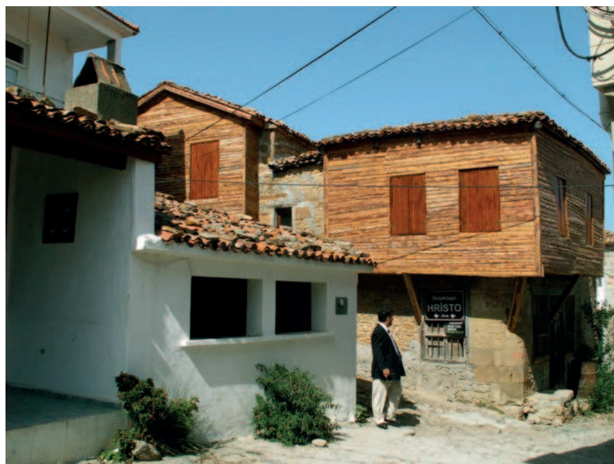
Ryc. 5. Charakterystyczna zabudowa tureckich wysp: kamienny parter i drewniane piętro (fot. A. Podolska)
