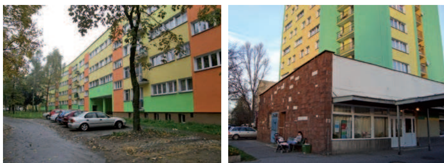
Ryc. 22. Elewacja budynku wielorodzinnego w osiedlu Tatory (fot. M. Sosnowska, 2010 r.)
