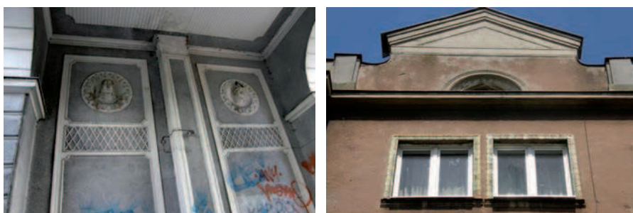
Ryc. 6. Pilastry i medaliony z popiersiami we wnętrzach bram przejazdowych osiedla ZOR Zachód (fot. M. Sosnowska, 2010 r.)
