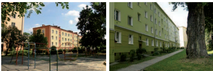
Ryc. 2. Zabudowa osiedla RDM i plac zabaw na wewnętrznym dziedzińcu (fot. M. Sosnowska, 2010 r.)
