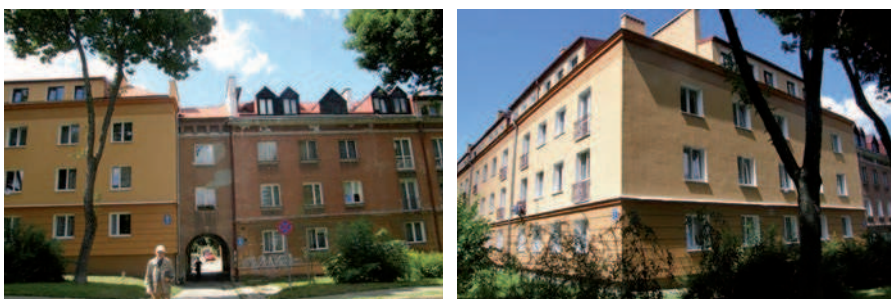
Ryc. 4. Zabudowa mieszkaniowa osiedla ZOR Zachód, widoczna brama prowadząca na wewnętrzną dziedzińcic (fot. M. Sosnowska, 2010 r.)
