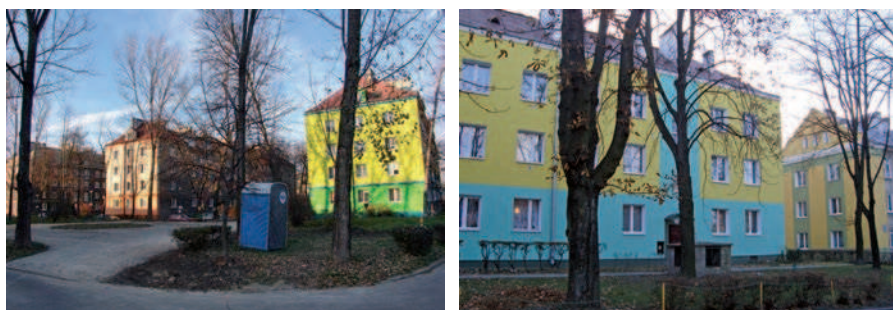
Ryc. 24. Nowa kolorystyka elewacji budynków najstarszej części osiedla ZOR Tatory (fot. E. Przesmycka, 2010 r.)
