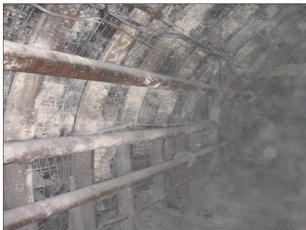
Rys. 24. Odrzwia SPŁ6.8-7.2/3.5/V29 ze stali S550 zabudowane w chodniku nadścianowym 3-Z1,Z2 w pokładzie 510/2 w KWK „Jas-Mos”
