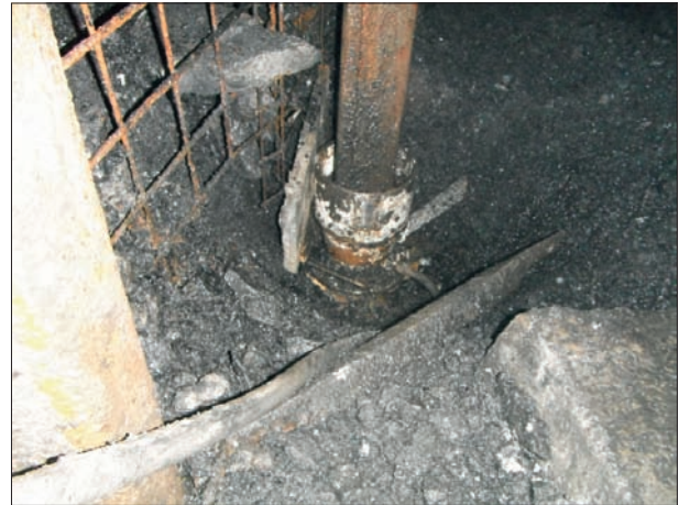
Rys. 22. Odrzwia ŁPw zabudowane w dowierzni 3. badawczej w pokładzie 504 w KWK „Bobrek-Centrum”
