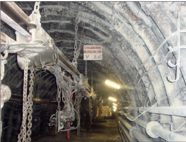
Rys. 23. Obudowa o podwyższonych parametrach mechanicznych II generacji zabudowana w chodniku nadścianowym ścian 6/VI/385, w pokładzie 385 w LW „Bogdanka” SA
