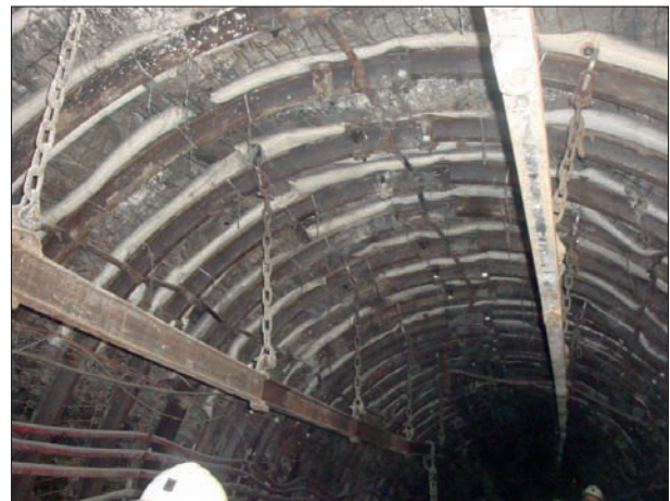
Rys. 23. Obudowa o podwyższonych parametrach mechanicznych II generacji zabudowana w chodniku nadścianowym ścian 6/VI/385, w pokładzie 385 w LW „Bogdanka” SA
