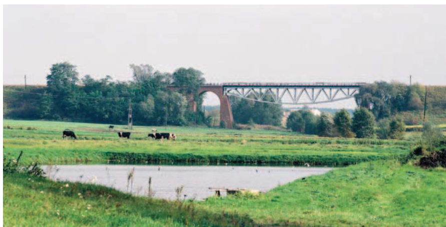
Ryc. 9. Najwyższy most-wiadukt kolejowy w Wielkopolsce o wys. ok. 20 metrów na nieczynnej linii kolejowej z Szamotuł, przez Ostroróg, Sieraków do Międzychód, Chrzypsko Małe, gm. Chrzypsko Wielkie, pow. międzychodzki
