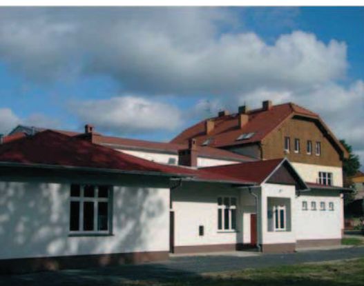
Ryc. 14a i 14b. Remont połączony z modernizacją budynku świetlicy wiejskiej w Mściwojowie (gm. Mściwojów, woj. dolnośląskie), źródło: http://www.msciwojow.pl/pl/Swietlice-wiejskie,143
