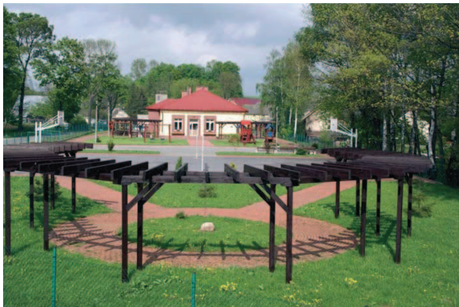
Ryc. 5. Centrum Aktywności Wiejskiej w Rudziczce (gm. Prudnik, woj. opolskie), źródło: archiwum własne autora
