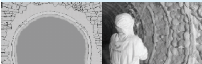
Ryc. 1. a, b. Natryskowe pianowanie obrysu chodnika Źródło: [5].
