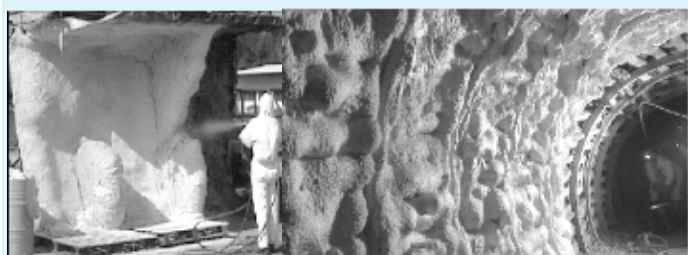
Fot. 1 a, b. Przykłady natrysków piany Minoterm Źródło: [5].
