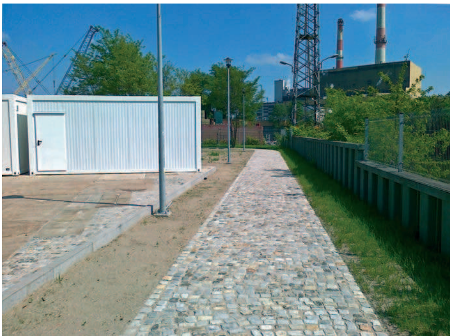
Ryc. 5. Budowa ścieżki edukacyjnej (wrzesień 2011 r.)
