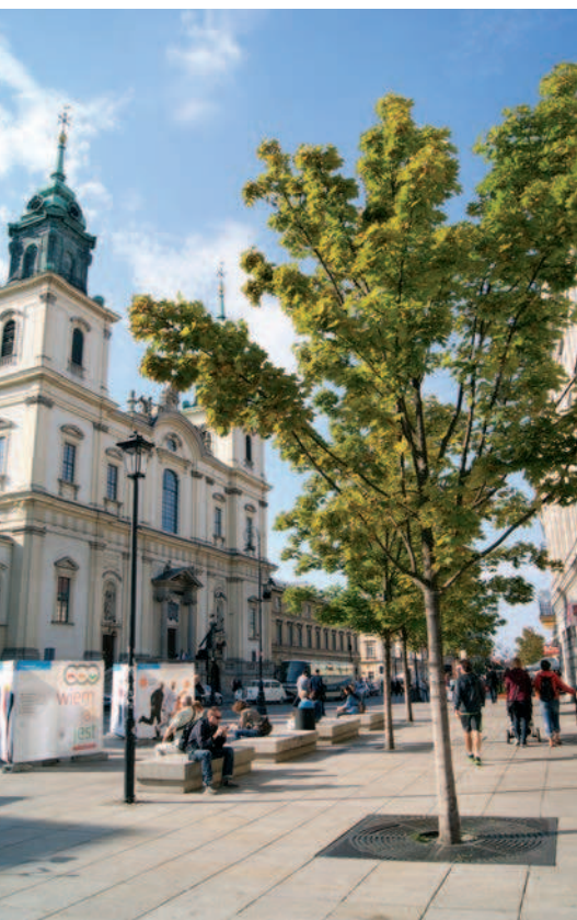
Ryc. 4. Chodnik na Krakowskim Przedmieściu w Warszawie wykonany w systemie Greenleaf Arborsystem (firmy GCL sp. z o.o.) umożliwia infiltrację wód deszczowych i zasilane nimi systemów korzeniowych drzew (fot. autor)
