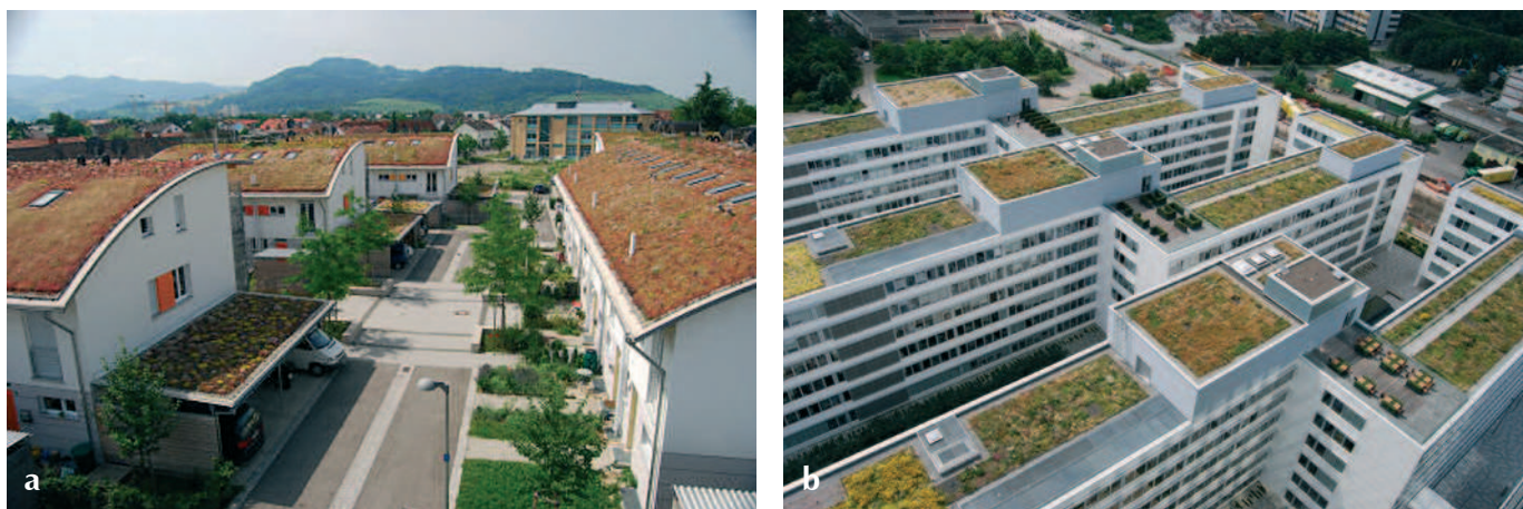
Ryc. 3. Zwiększenie retencyjności obszarów zabudowanych przez zastosowanie dachów zielonych a) domy szeregowe osiedla „Rosengarten” we Freiburg, b) kompleks biurowy w dzielnicy przemysłowej na wschód od Stuttgartu Fasanenhof (źródło: rozwiązania systemowe Optigrün)
