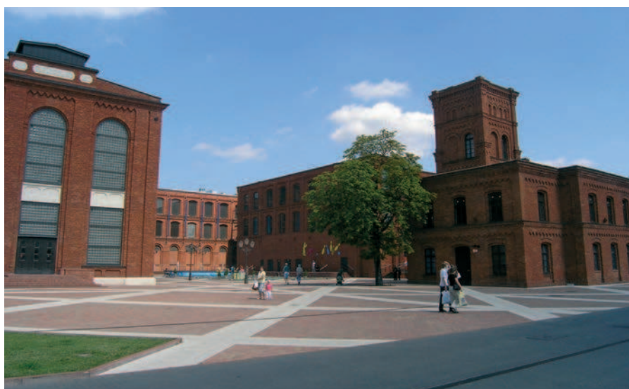
Ryc. 8. „Manufaktura Łódzka”. Zespół budynków fabrycznych odnowiony, adaptowany do nowych funkcji, pozbawiony pierwotnego układu urbanistycznego daje uczucie nieładu przestrzennego, przypadkowości
