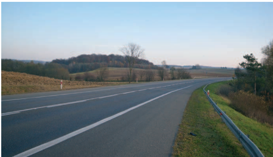
Ryc. 3. Droga krajowa nr 7 (Gdańsk – Warszawa) na terenie gminy Ostróda, Idzbank (październik 2010 r.)
