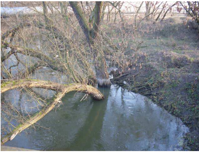
Rys. 4. Kanał Mosiński, drzewa rosnące w kanale (pozycja: 52°15'2.84"N; 16°51'38.50"E) Fig. 4. Canal Mosinski, trees growing in the water-course (position: 52°15'2.84"N; 16°51'38.50"E)
