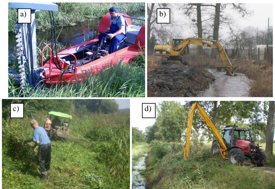
Rys. 2. Różne zabiegi wykonywane przez spółki wodne w zakresie renowacji rowów i kanałów melioracyjnych: a) wykaszanie łódkami na dużych kanałach i rzekach, b) odmulanie dna koparką gąsienicową, c) wykaszanie ręczne i mechaniczne, d) wykaszanie kosiarką z podbierakiem [11]
