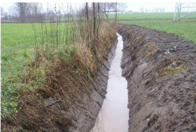
Rys. 6. Rów melioracji szczegółowej w Kromolicach, po renowacji Fig. 6. Detailed land improvement ditch in Kromolice, after renovation
