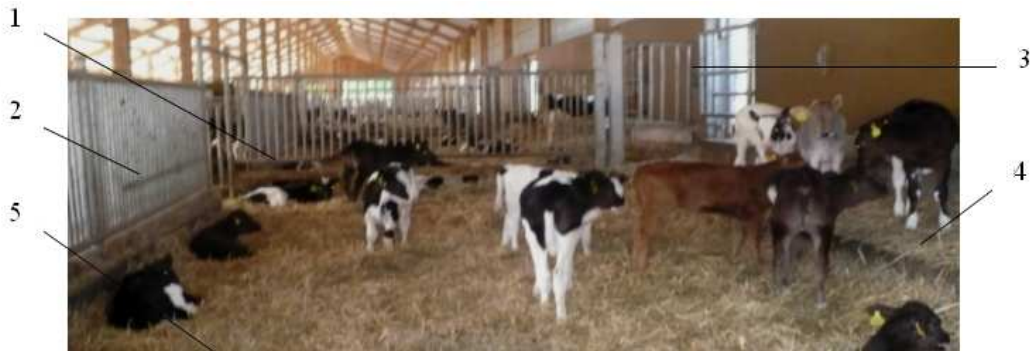
Rys. 2. Grupowe kojce dla cieląt: 1 – przegroda między kojcami, 2 – ściana boczna, 3 – bramka, 4 – część legowiskowa podwyższona, 5 – ściółka głęboka
