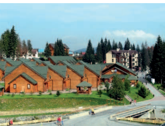
Ryc. 5. Otoczenie hotelu Bukovel
