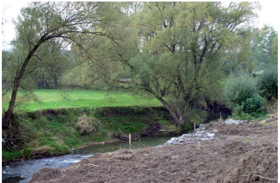
Ryc. 2. Stabilizacja brzegu rzeki Stobnica
