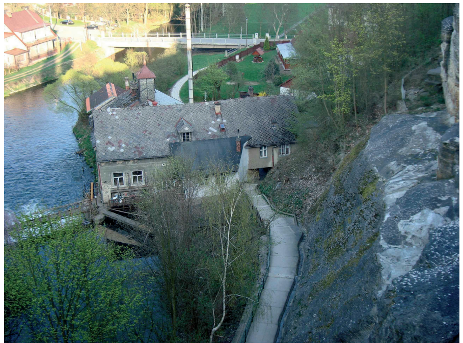
Ryc. 18. Widok na drogę przejazdową przez młyn (fot. Z. Borcz)
