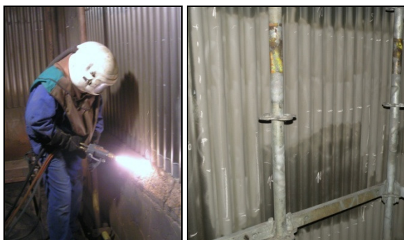
Rys. 9. Powłoki ochronne w kotle fluidalnym: a) proces regeneracji powłoki, b) obszar regenerowany po 9 latach eksploatacji
