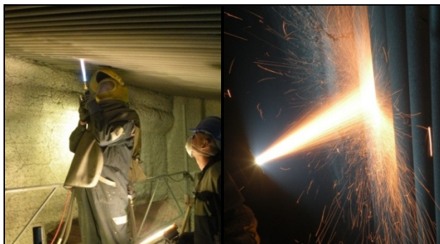
Rys. 3. Natryskiwanie cieplne powłok na elementach kotłów energetycznych metodą: a) HVOF, b) łukową
