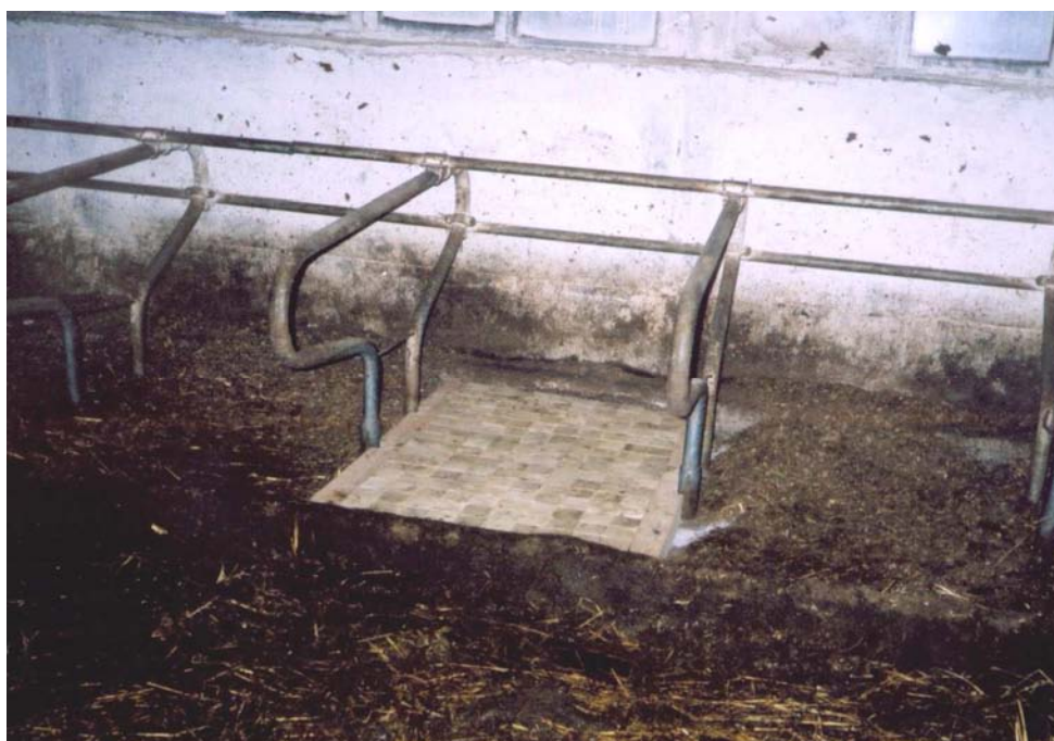
Rys. 1. Widok legowiska pokrytego brukiem drewnianym (bezpośrednio po zamontowaniu)
