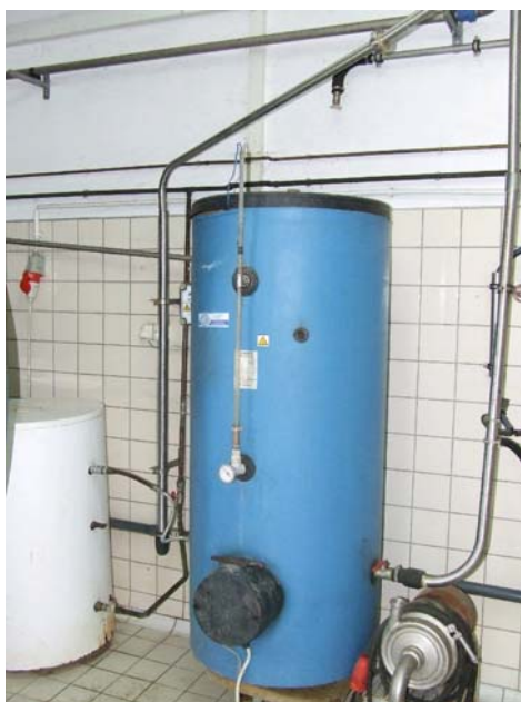
Rys. 3. a) nakłady energetyczne i ekonomiczne badanych obiektów w miesiącu, b) zbiornik podgrzewający wstępnie wodę do mycia oraz główny zaizolowany zbiornik w gospodarstwie nr 1 Fig. 3. a) Monthly energy inputs and costs in tested objects, b) tank preheating water for washing and the main insulated water tank on the farm no. 1
