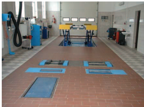
Rys. 4. Linia osobowa firmy Unimetal (urządzenia wbudowane w posadzkę i podnośnik nożycowy)
