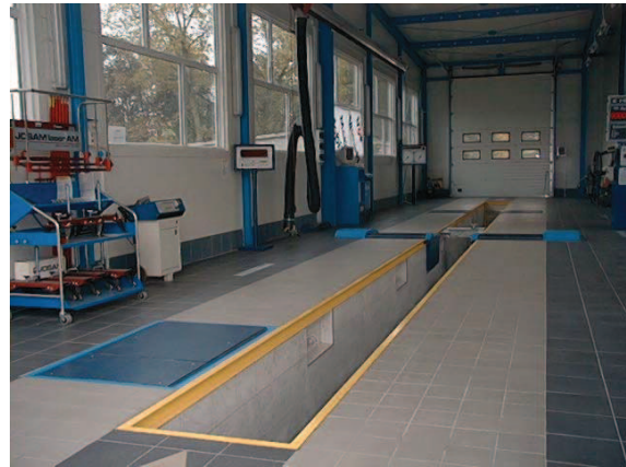
Rys. 8. Widok linii ciężarowej Uniline-3000 (źródło: Unimetal)
