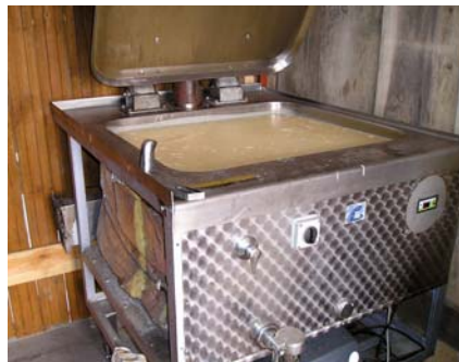
Rys. 6. Wygląd „paliwa” do zasilania generatora Fig. 6. View of “fuel” supplied to the generator
