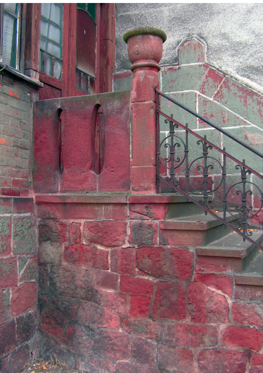
Kamienne schody przy ul. Kłodzkiej 9 (Słupiec)
