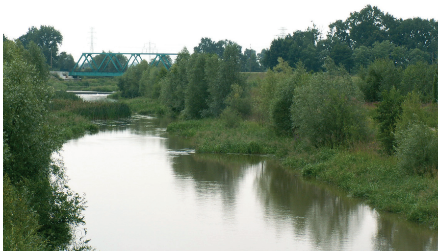
Most kolejowy na rzece Oławie w Siechnicach
