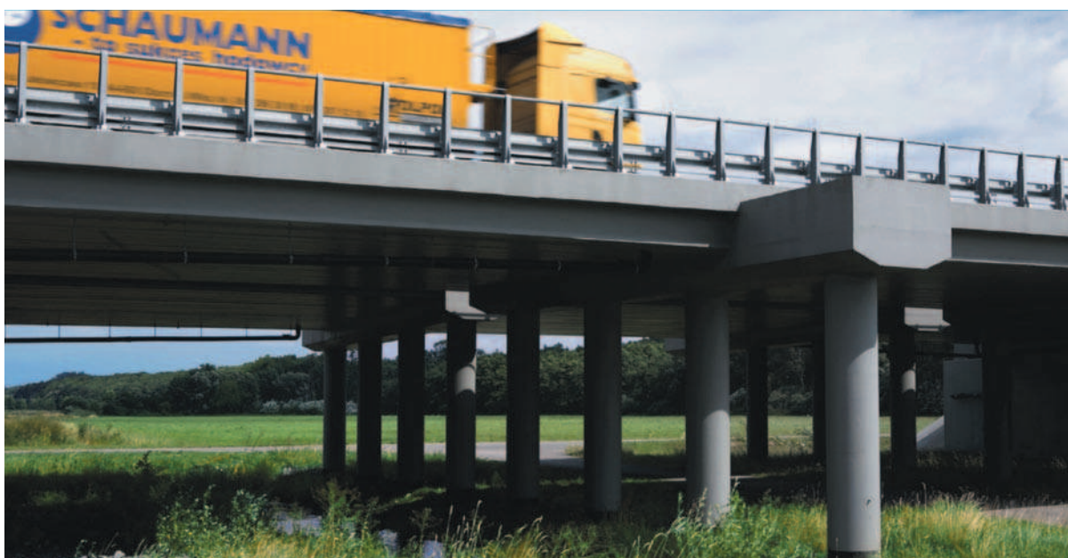
Rys. 2. Przejście dla zwierząt dołem na podmokłym biotopie wybudowane na autostradzie A-2 w okolicach poznania. Z przejścia tego korzysta zwierzyna kopytna oraz małe ssaki, takie jak np. wydry czy też jenoty i borsuki.
