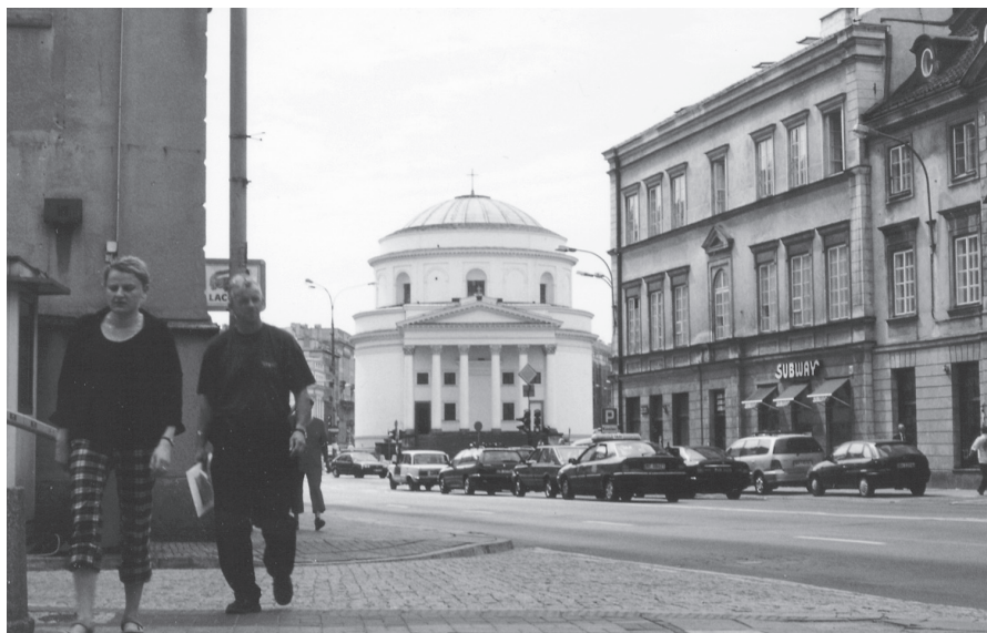
Widok na północną elewację kościoła pod wezwaniem św. Aleksandra przy pl. Trzech Krzyży
