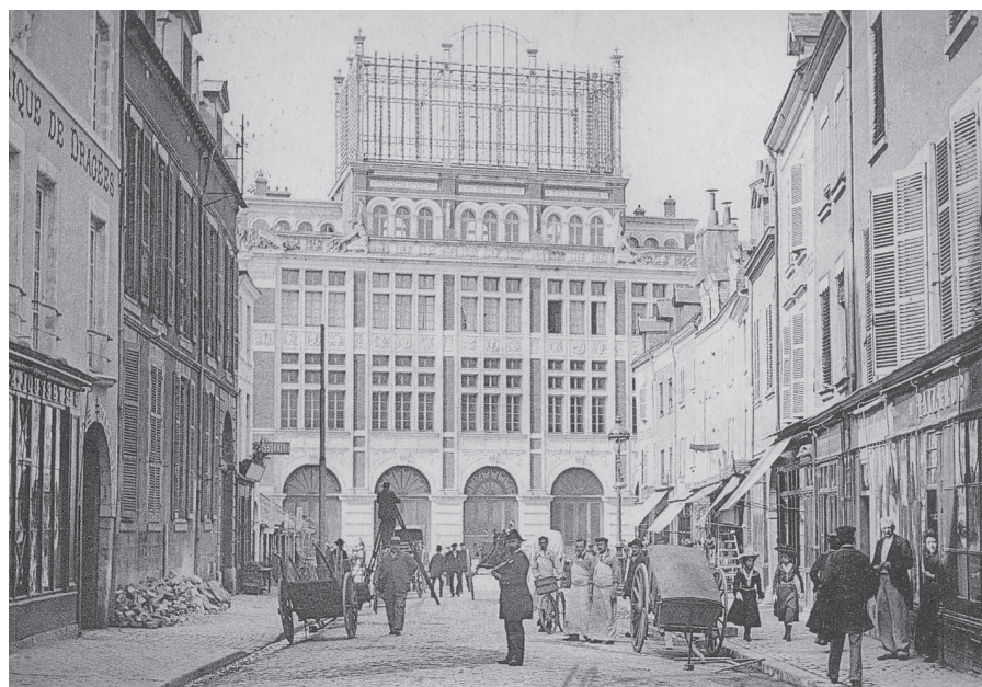
Orlean (Francja) – budynek pocztowy ze stacją nadawczą telegrafu elektrycznego Poczta z 1915 roku. Zbiory własne
