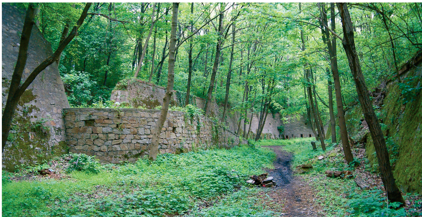
Fosa wewnętrzna, widok na kontrgardę I obok rawelinu Pomorze
