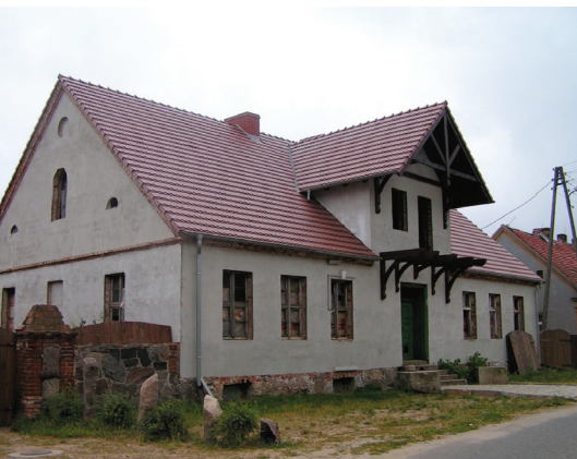
Budynek mieszkalny we wsi Wysoka
