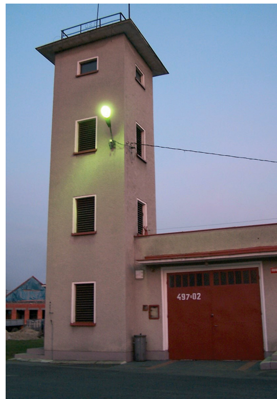
Remiza strażacka we wsi Osiek koło Opola (źródło: archiwum Instytutu Architektury Krajobrazu AR we Wrocławiu)
