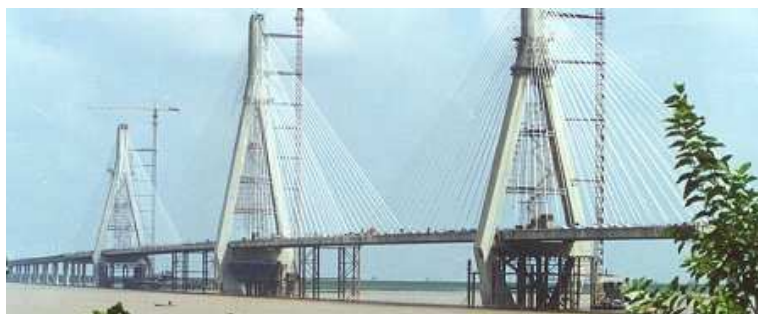
Rys. 1. Most Dong Ting Lake (Chiny) zawierający magnetoreologiczne tłumiki minimalizujące wpływ wiatru na przemieszczenia mostu [3]
