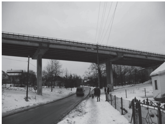
Rys. 1. Widok badanego wiaduktu
