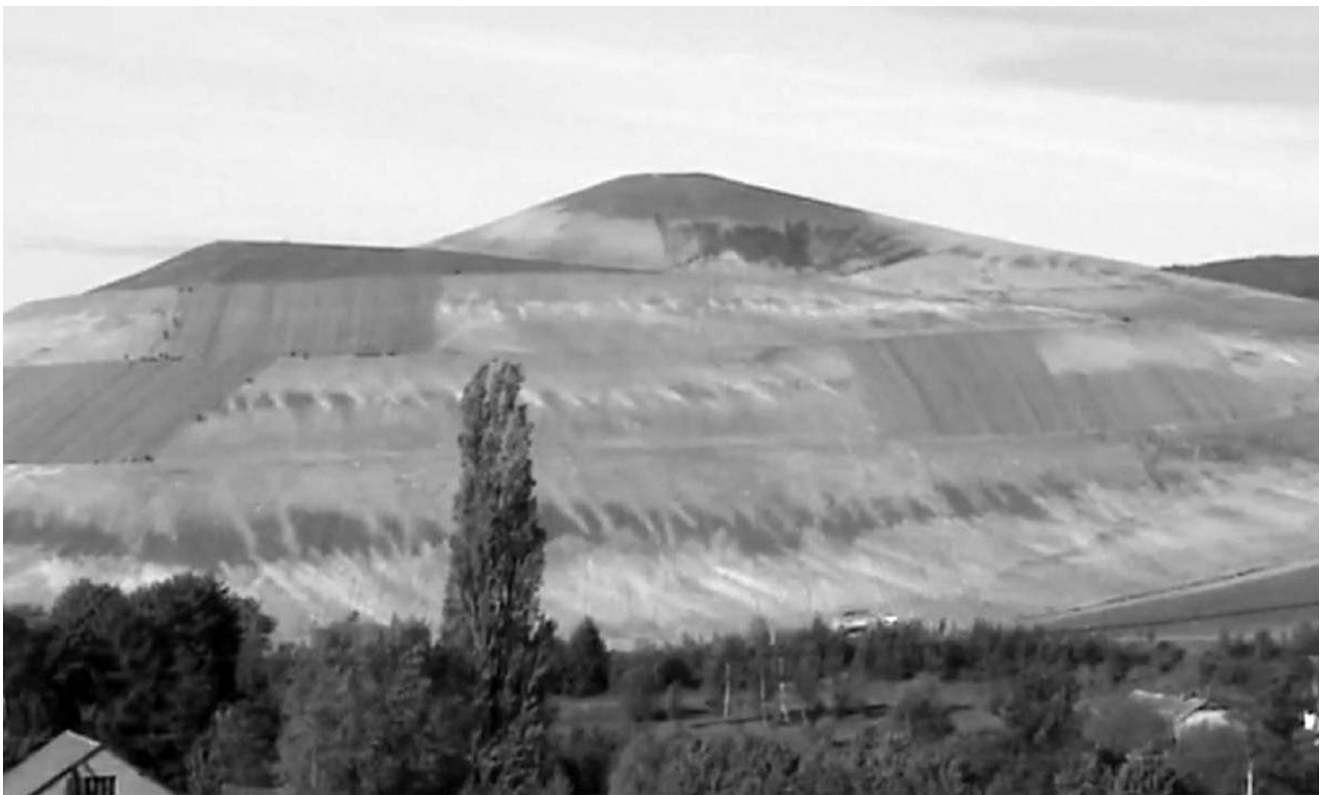
Rys. 6 Hałda Centralna po hydroobsiewie i zastosowaniu mat kokosowych [1]
