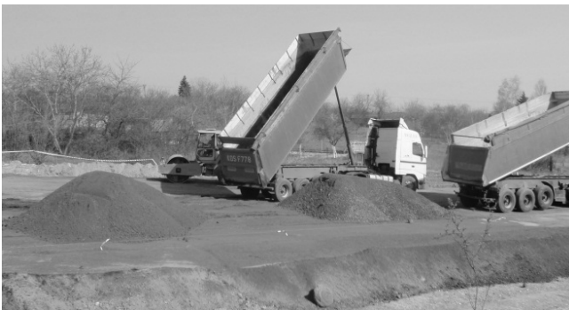
Rys. 5 Inst. Budowa obwodnicy Chrzanowa z zastosowaniem mieszanki kruszywowo–popiołowej z ZG Sobieski
