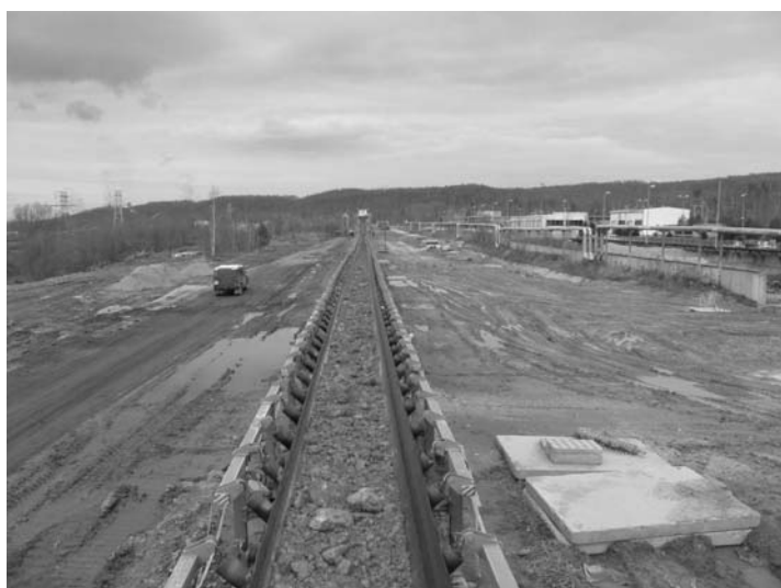
Rys. 6. Zasypana wyrwa i odbudowany ciąg ON-3
