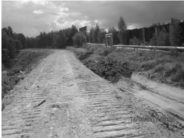
Rys. 15. Odtworzony nasyp na potoku Śład
