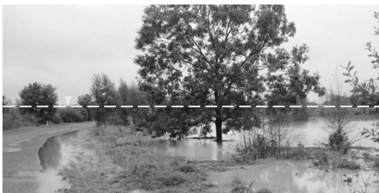
Rys. 8. Przecieki na wale przeciwpowodziowym z rozlewiska Nysy Łużyckiej do odkrywki
