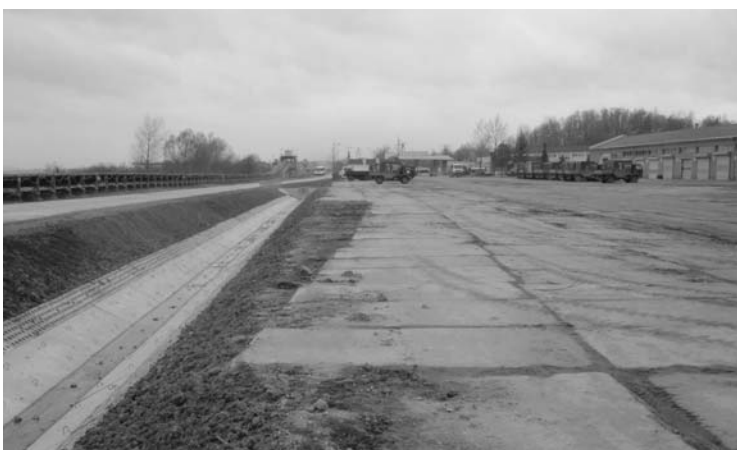
Rys. 4. Zasypana wyrwa i odbudowany ciąg ON-1
