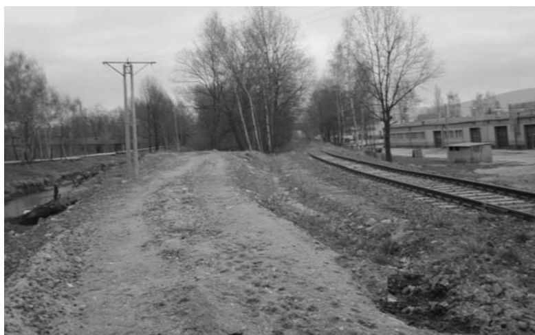
Rys. 10. Odtworzony nasyp w miejscu wdarcia się do odkrywki w rejonie trasy przenośnika bazy ON-1 przy bazie transportowej
