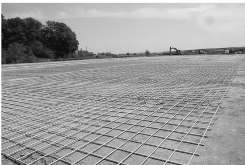
Fot. 6. Warstwa transmisyjna wzmocniona siatkami stalowymi
