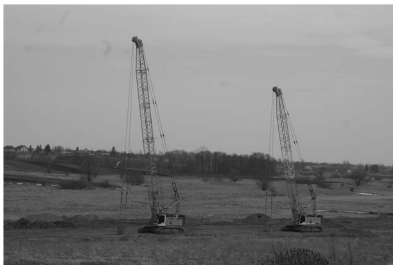
Fot. 2. Urządzenia kafarowe podczas wykonywania konsolidacji dynamicznej
