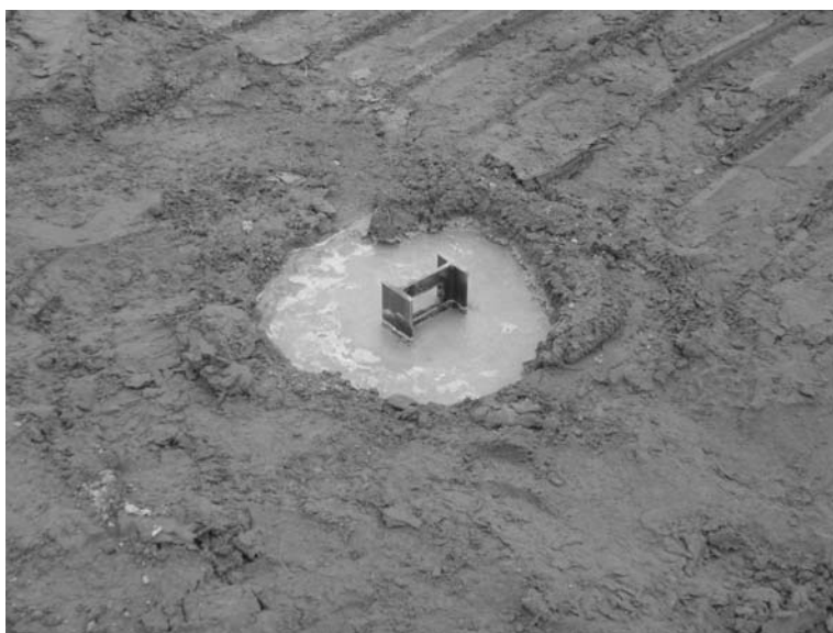
Fot. 5. Kolumna CMC zazbrojona dwuteowym kształtownikiem stalowym
