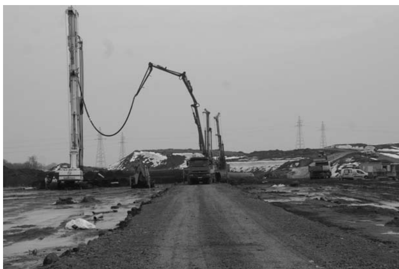
Fot. 3. Pompowanie mieszanki betonowej przez otwór umieszczony w rdzeniu świdra
