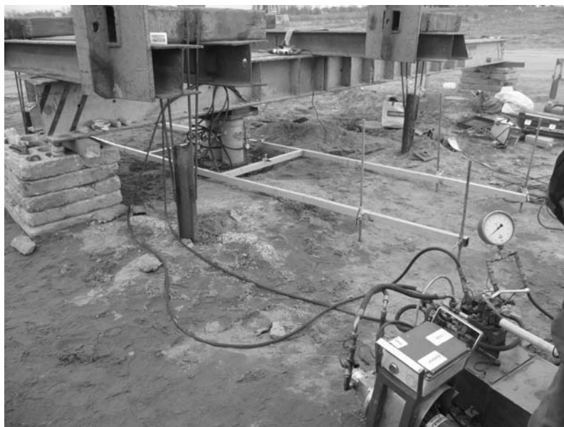
Fot. 4. Wykonywanie próbnych obciążeń kolumn CMC
