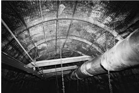
Rys. 15. Przecinka ścianowa nr 30 w pokł. 405/3 w obudowie łukowej podporowo-kotwiowej
