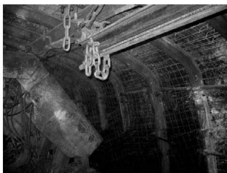
Rys. 7. Widok wprowadzonej sekcji obudowy zmechanizowanej do przecinki ścianowej nr 31 w pokł. 405/1
