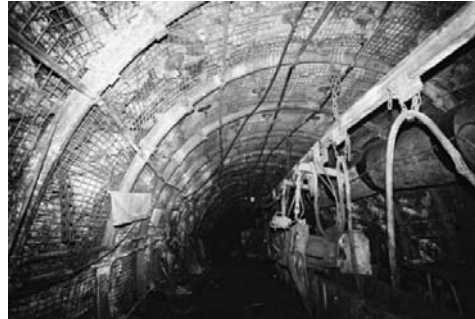
Rys. 16. Przecinka ścianowa nr 30 w pokł. 405/3 w obudowie łukowej podporowo-kotwiowej
