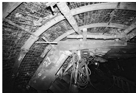
Rys. 14. Widok przecinki ścianowej nr 2 w pokł. 408/3 z wprowadzoną sekcją obudowy zmechanizowanej
